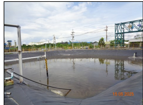
ภาพที่ 2.2-12 บ่อพักน้ำทิ้งฉุกเฉิน
