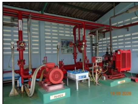
ภาพที่ 2.2-56 ปั๊มส่งน้ำชนิดเครื่องดีเซล
