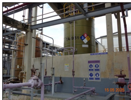
ภาพที่ 2.2-37 ถังเก็บโซเดียมไฮดรอกไซด์ พร้อมคันคอนกรีต
