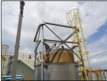
ภาพที่ 2.2-1 ระบบรวบรวมก๊าซมีเทน ที่เกิดจากระบบ UASB
