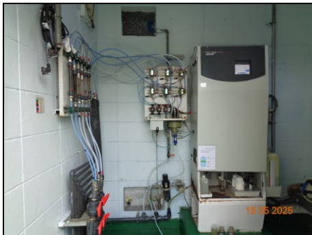
ภาพที่ 2.2-11 เครื่องตรวจวัด คุณภาพน้ำทิ้งอัตโนมัติ บริเวณบ่อพักน้ำทิ้ง
