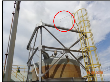
ภาพที่ 2.2-2 อุปกรณ์ตรวจวัดก๊าซมีเทน บริเวณถังปฏิกรณ์ UASB
